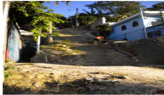
Calle El Olympo: possible drainage project
